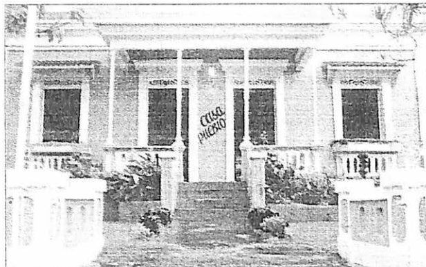
□ FACHADA QUE alberga a Casa Pueblo, en Adjuntas, entidad creadora del Plan de Conservación.
