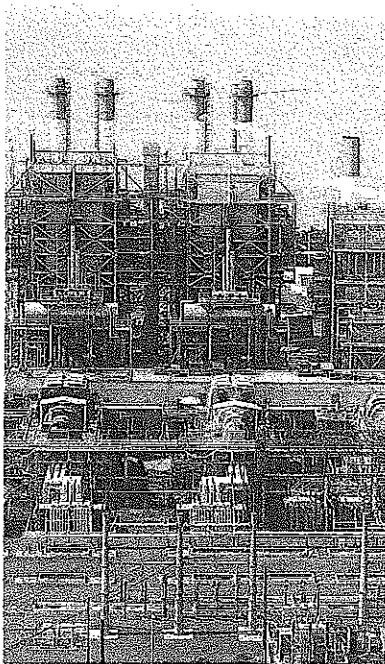
'Vía Verde' contempla la costosa construcción de una nueva planta más la conversión de seis turbinas de la actual.
