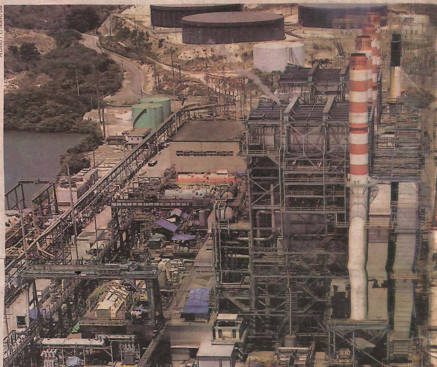
Puerto Rico depende casi exclusivamente de la energía que generan plantas de la AEE, como la central termoeléctrica Costa Sur.
