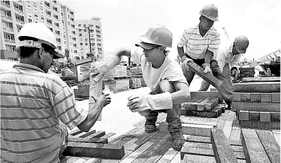
LAS OBRAS en el muelle 6 del proyecto Bahía Urbana, frente al Departamento de Hacienda, podrían estar terminadas para el 31 de agosto.
